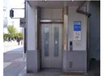
エレベーターで地上階へ。
